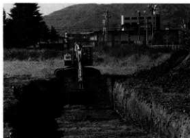
I-2 重機による表土剥ぎ（A区）
