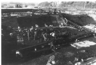
左 SD101 調査風景 右 SD101 調査風景
