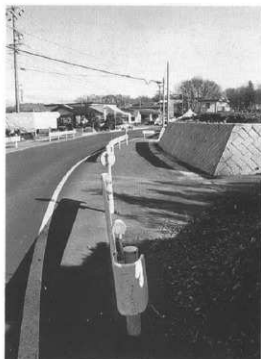
写2 寺中遺跡工事終了状況 (西から)
