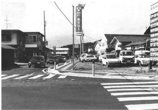
工事完成風景 (雨より)
