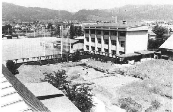
兖州调金区西侧远景
