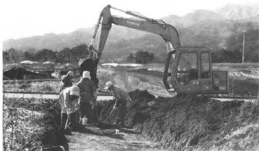
重機を用いてトレンチを掘り進める
