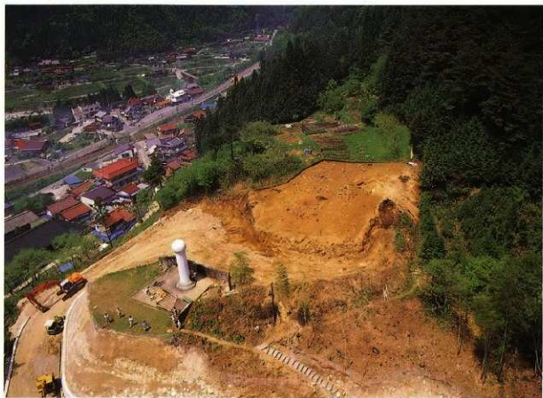
遺跡遠景（南西上空より）
