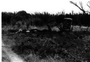
重機にて試掘調査
