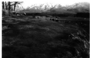
写真5 7年度D～F区検出作業 (西から)
