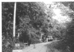
家老路城跡 工事立会
