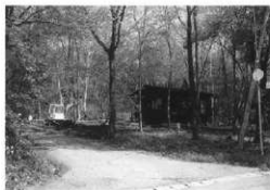
清明台遺跡 工事立会
