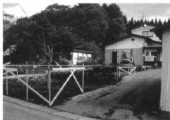
落影(五厘山)遺跡 工事立会
