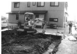
東裏遺跡 工事立会
