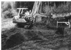
霊仙寺遺跡 工事立会
