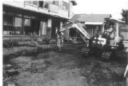
東裏遺跡 工事立会
