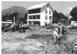
上ノ原遺跡 工事立会
