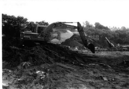
重機作業風景
