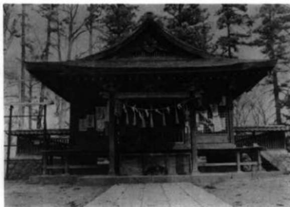
一間の格子戸は他の柱間と同じく上部、下板壁であったことが、柱に残る腰貫、板溝の痕跡からわかる。向拝・縁・垂木以上・天井・建具は後世の改造である。
