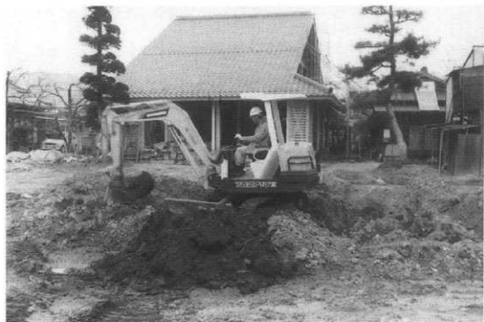
重機作業風景
