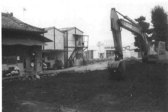
重機作業風景
