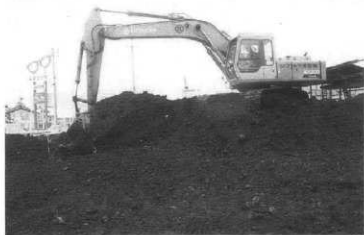
重機作業風景
