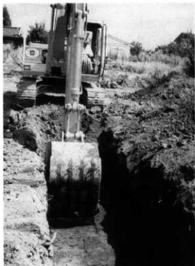
トレンチによる試掘調査
