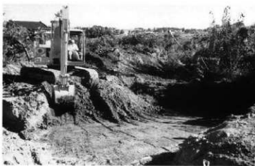
重機による 表土剥ぎ作業
