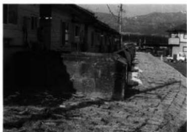
現存している格納庫の基礎部分（建築当時の鉄筋がむき出しになっている）（保育所の南側）
