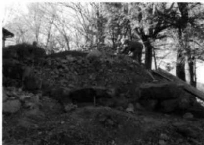
⑥石垣の解体（人力による裏込石の撤去作業）
