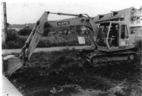
重機作業風景
