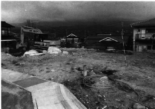
調査地調査前 北西から
