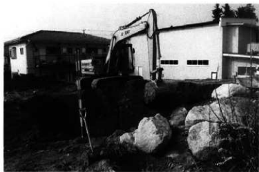
重機による表土剥ぎ
