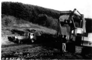
富田窯址ぎわに工事がせまる
