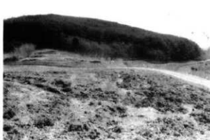
富田窯址 — 工事後
