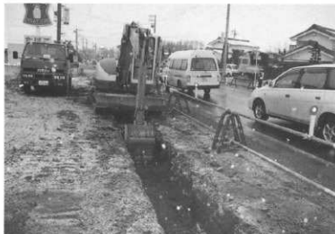
図版15 中金井遺跡群立ち会い調査風景
