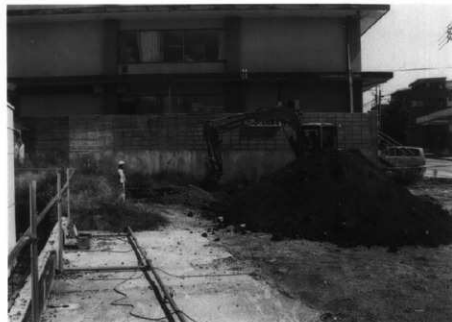
重機作業風景
