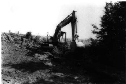
重機作業風景
