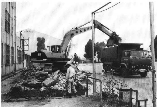
重機による部室取り壊しスナップ
