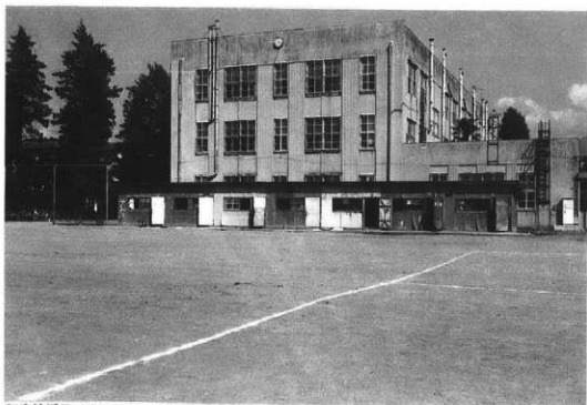
調査地近景（西より望む）
