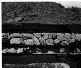
Ⅲ-8 2号石積み立面 (部分)
