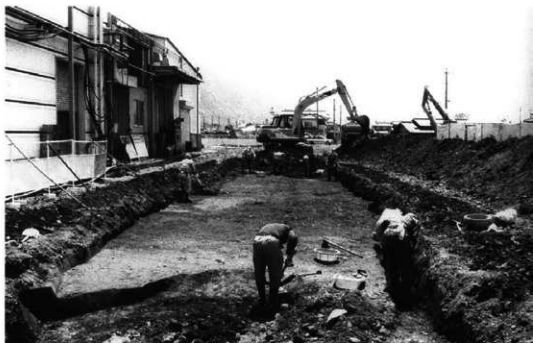
調査風景 (北西側より)
