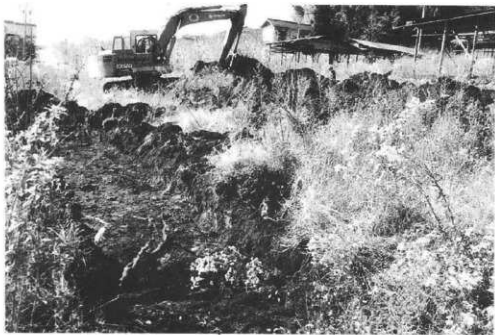
重機作業風景
