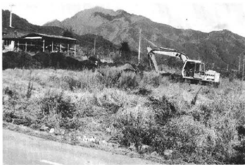
重機作業風景
