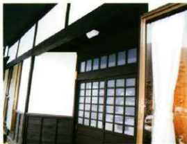
新しく作られた玄関（小海町） 部屋だった部分を新しく玄関に替えた。
