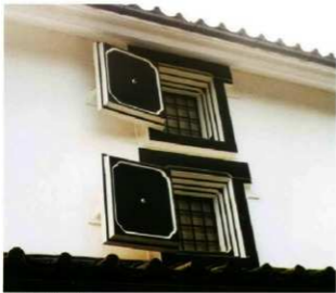
厚い扉のある窓 銅の格子と金網が貼られていて、虫の侵入を防ぐ。
