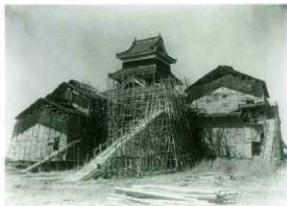
松本城昭和の修理（松本市立博物館提供）
