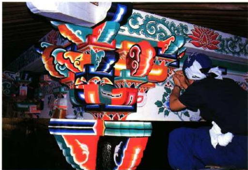
軒下の彩色文様修復中のようす 彩色修復では、再塗装りと彩色の色落ちの補筆をする。
