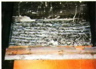
壁の中のかから 壁にかわらを並べて塗りこみ、簡単に破られないようにした例。
