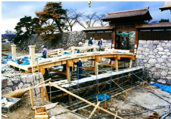
復元された松代城跡の太鼓門と橋（長野市） 一部に寸法が書かれていた江戸時代後期の絵図面や発掘調査をもとに復元されている。
