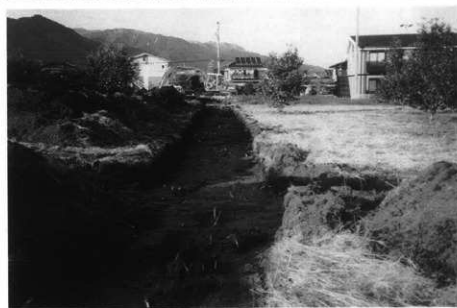
試掘調査 重機作業調査スナップ
