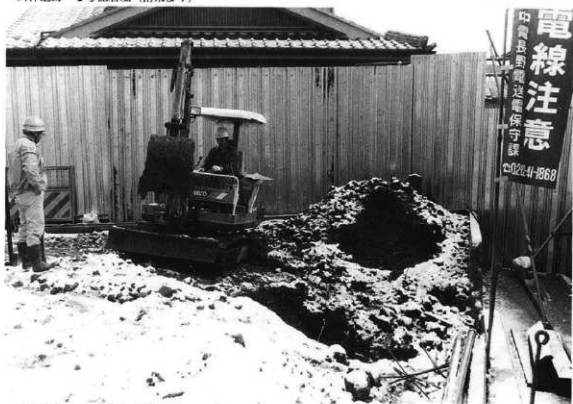
五十里道跡 調査風景 (西より)
