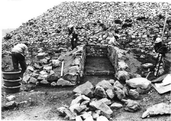
3号墳の復原工事（南側より）
