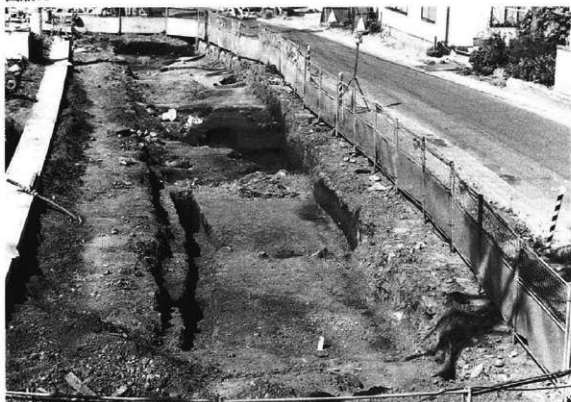
調査区南側全景
