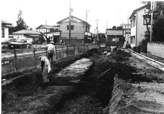
調査区北側調査風景
