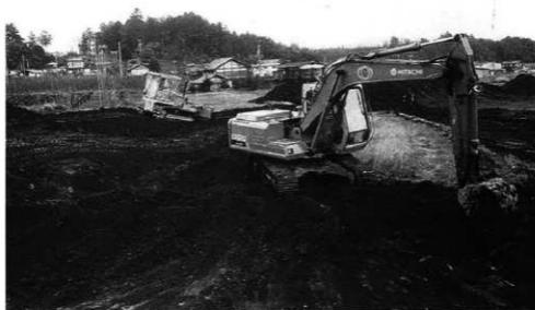
中村中平遺跡重機作業風景
