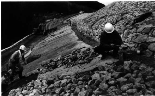
貼石帯整備工事 (北東から)
