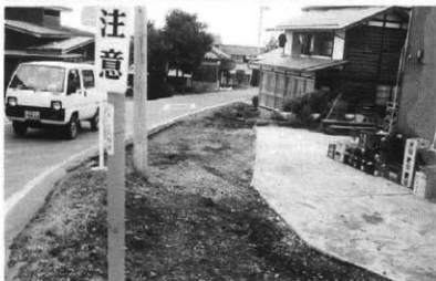
▷ 突堤前の状況(2) 突堤のため舗装部分除去
