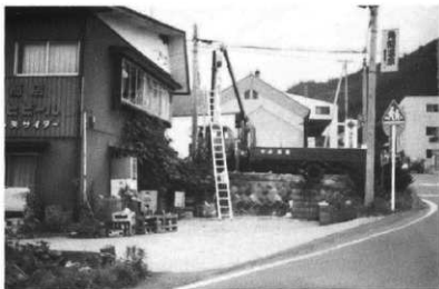
▷ 突堤前の状況(1) コンクリート舗装部分
