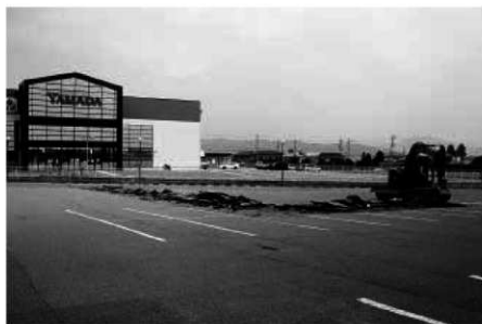
調査前風景（南西から）
