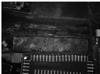
調査区全景（上が東）
