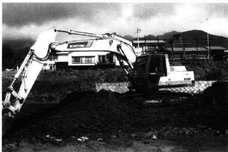
重機作業風景
