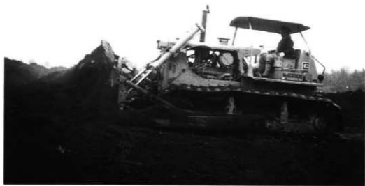
重機作業風景
