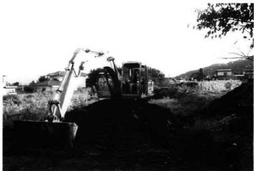
重機作業風景
