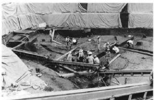
左: ◎b区調査風景 右: SB7502断面
