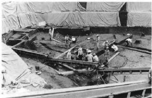
左: ◎b区調査風景 右: SB7502断面
