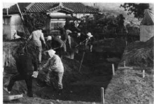
第5地点 Kトレンチ埋戻し
