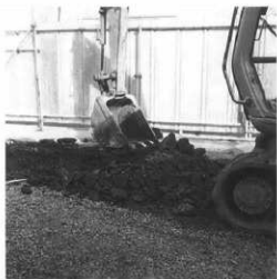
トレンチ掘削状況
