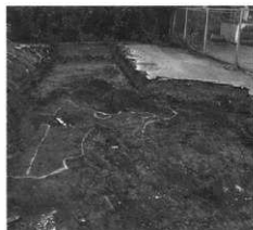
トレンチ掘削状況
