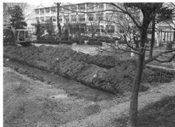
薊沢遺跡トレンチ近景
