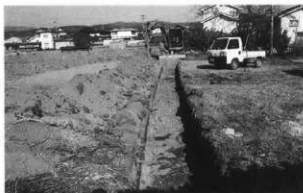
新町遺跡調査地点 (北方から)
