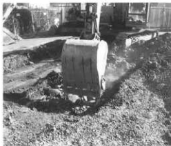
トレンチ掘削状況
