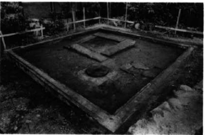
22 土台石不同沈下
