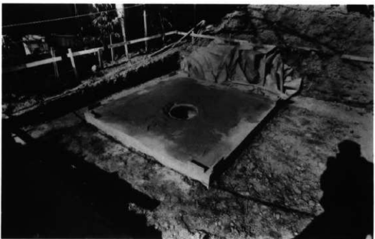
44 同上 据付完了
