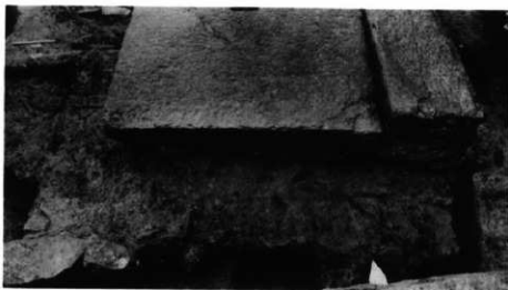
78 北側土台石下部
