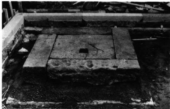
51 敷石土台石据付完了
