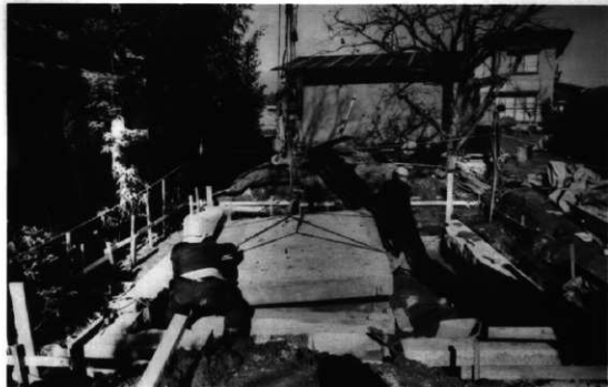
45 コンクリートスラブ据付完了
