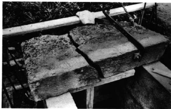
25 屋根石(背面側)取外し中
