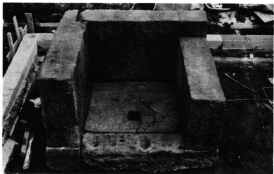
52 壁石積上げ完了(一段)
