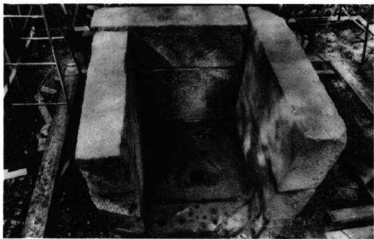
28 屋根石取外し完了
