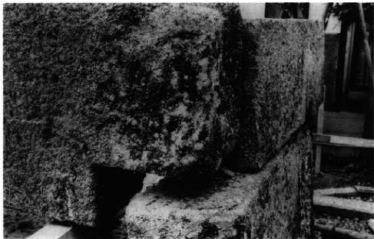
29 壁石取外し中（北東隅上段）
