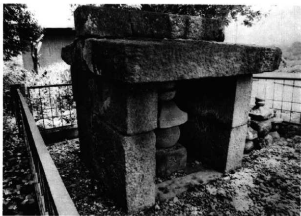
5 修理前 正面面(南西面)
