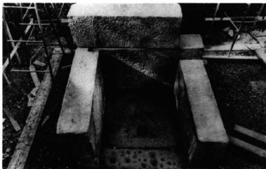
31 壁石取外し中
