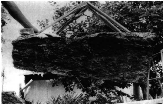
26 屋根石取外し中（背面東側）
