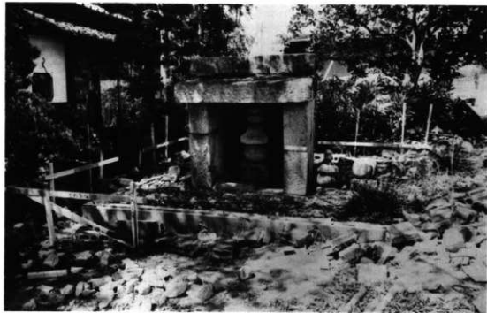
23 保護柵解体中
