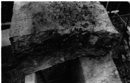
27 屋根石取外し中（背面西側）
