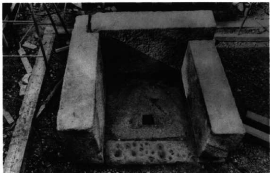
32 壁石取外し中
