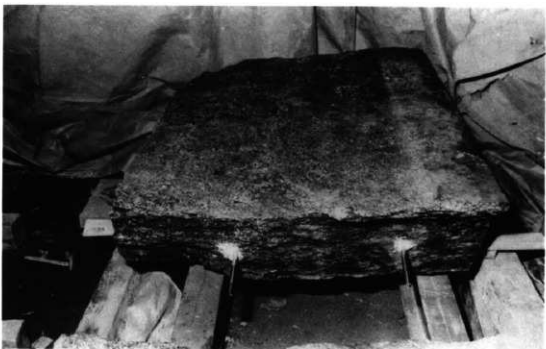
49 屋根石破断面ステンレス筋挿入
