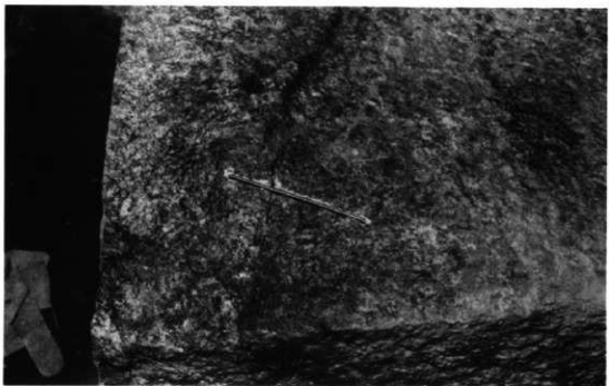
47 屋根石亀裂部錠補強
