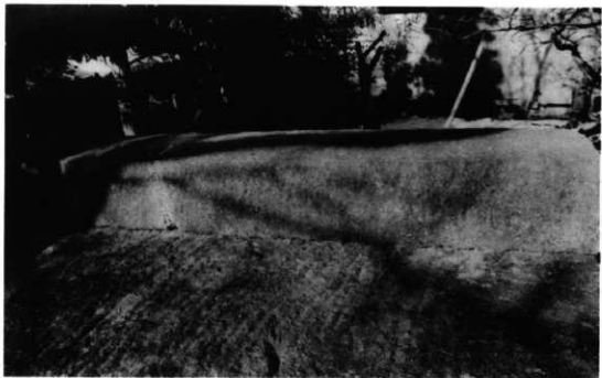
55 礎石据付完了
