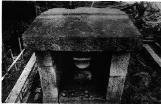
54 屋根石据付完了
