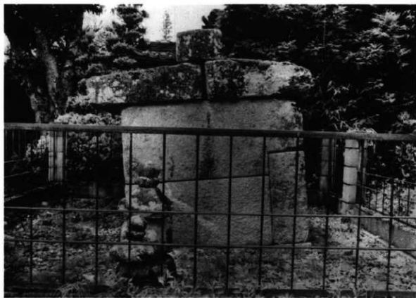
9 修理前 側面（東面）
