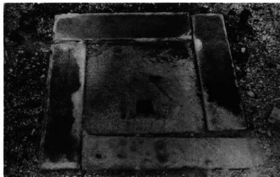
34 壁石取外し完了
