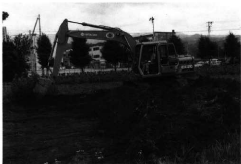
重機作業風景
