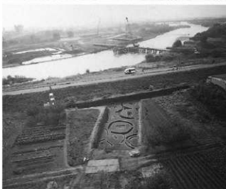
左 平成5年度調査分 1A区遠景 右 1A区北側 調査前風景
