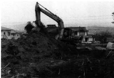
重機による表土剥ぎ
