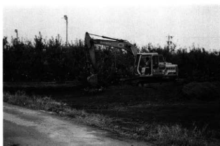
重機作業風景
