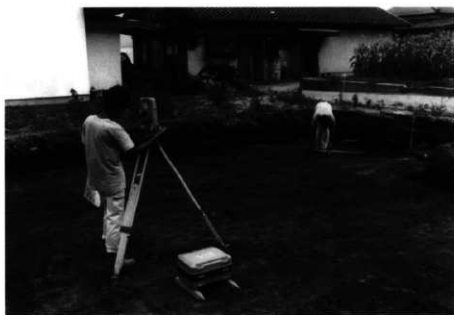
基準点設置作業
