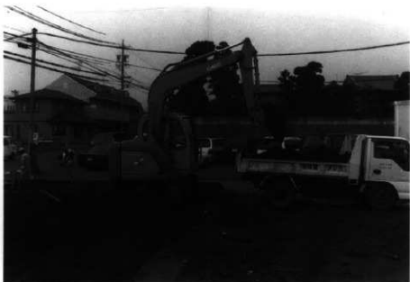
重機表土剥ぎ作業
