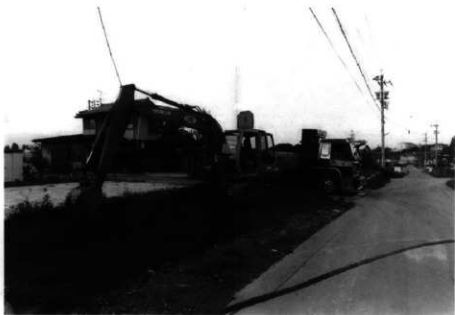
重機表土剥ぎ作業 (1775-6)
