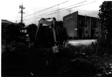
重機表土剥ぎ作業 (1778-1)
