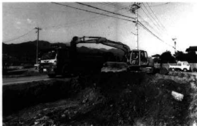
重機表土剥ぎ作業
