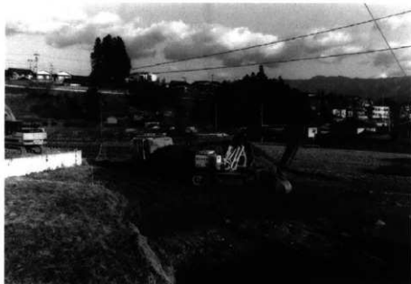
重機表土剥ぎ作業
