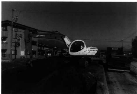
重機表土剥ぎ作業 (1772-1)
