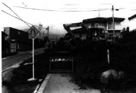
重機表土剥ぎ作業
