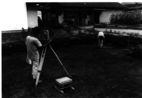
基準点設置作業
