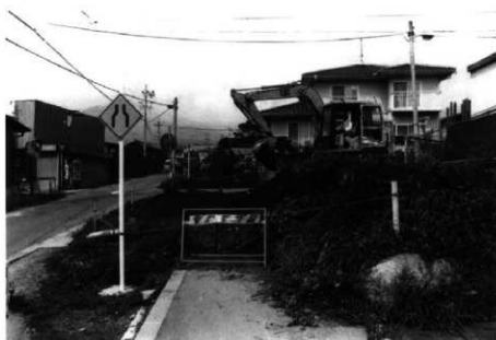
重機表土剥ぎ作業
