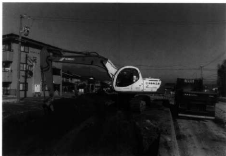
重機表土剥ぎ作業 (1772-1)
