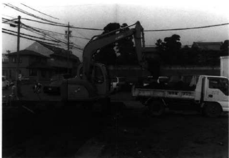
重機表土剥ぎ作業
