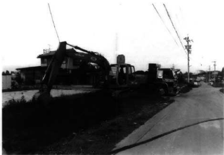
重機表土剥ぎ作業 (1775-6)
