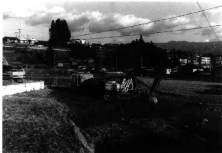
重機表土剥ぎ作業
