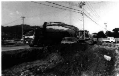
重機表土剥ぎ作業
