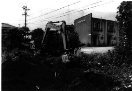
重機表土剥ぎ作業 (1778-1)
