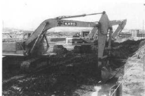
外周トレンチの掘削（更地条里遺跡J地区）
