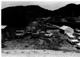
写真2 A区重機表土剥ぎ
