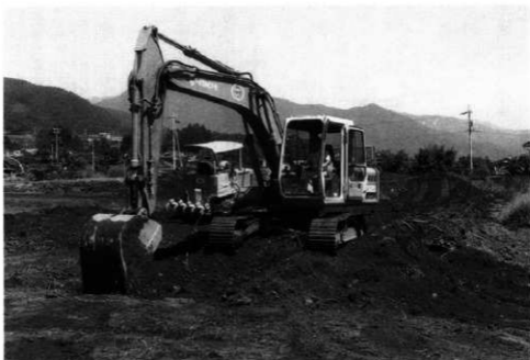
富士塚遺跡重機作業風景
