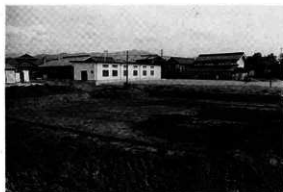
塩崎体育館地点土除去
