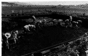
中部電力鉄塔地点検出作業
