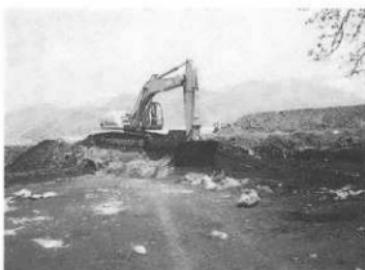
バックホーによる表土剥ぎ作業
