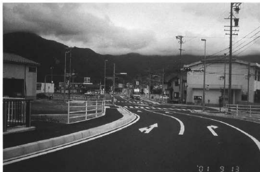
写真4 工事終了後の風景 (平成13年9月13日撮影)
